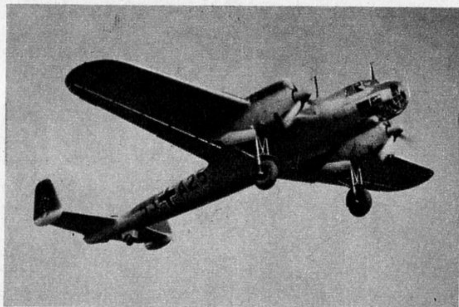
Fernaufklärer und Kampfflugzeug Dornier Do 17. Besatzung 3 Mann; Bewaffnung bewegliche MG
